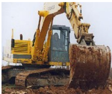
Engins de chantier
